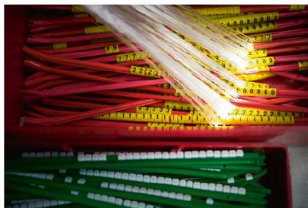
Figure 8 : Bagues à clipser à des fins d'identification des câbles
